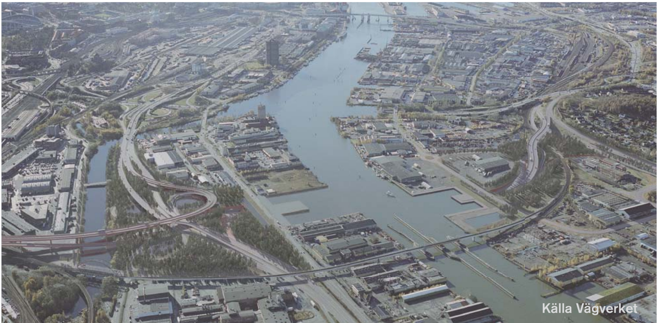
Marieforstunneln och dess anslutning i Marieforsmotet.
